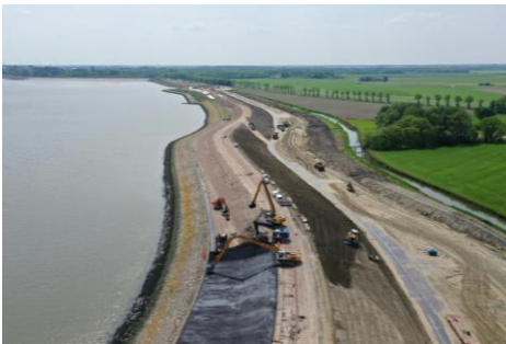
Beeld: POV kabels & leidingen
