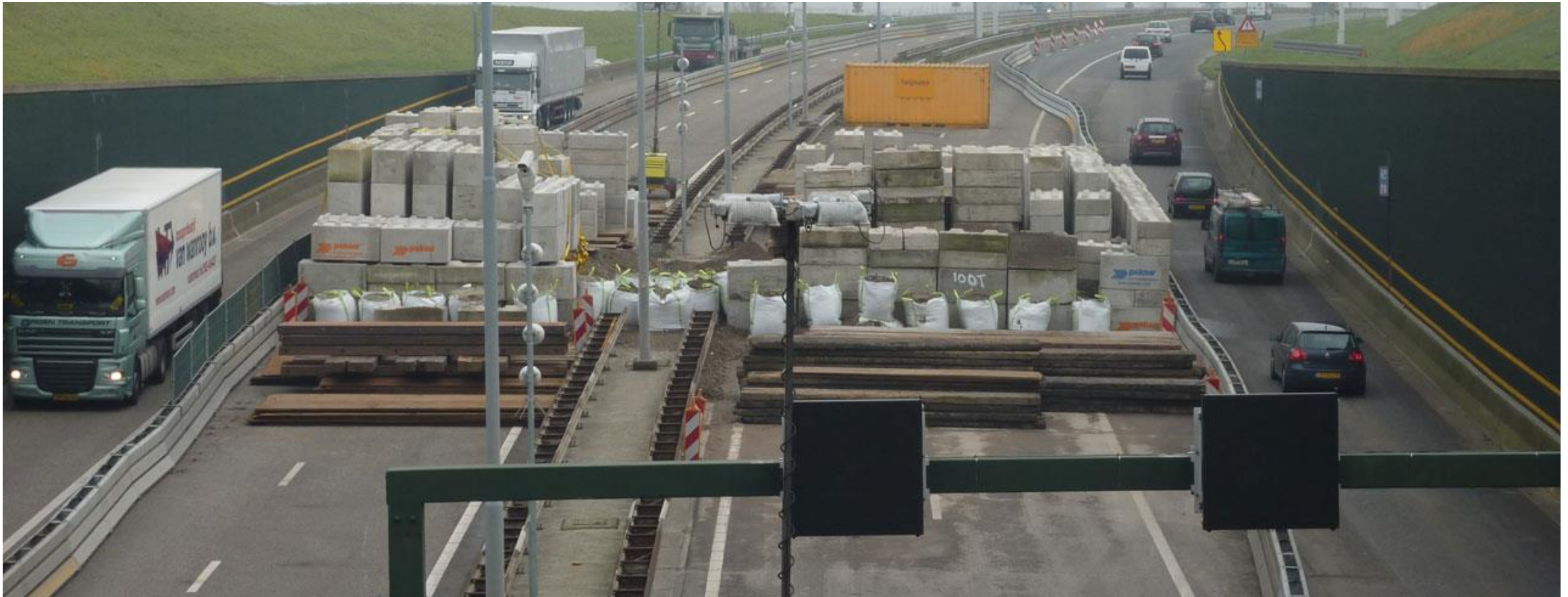
Door extra ballast op het wegdek te plaatsen, wist Rijkswaterstaat de omhoog gekomen bak weer op zijn plaats te krijgen. (Foto: beeldbank Rijkswaterstaat)
