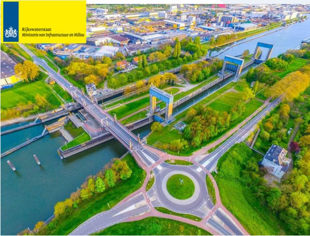
Sluiscomplex Weurt & Heumen
