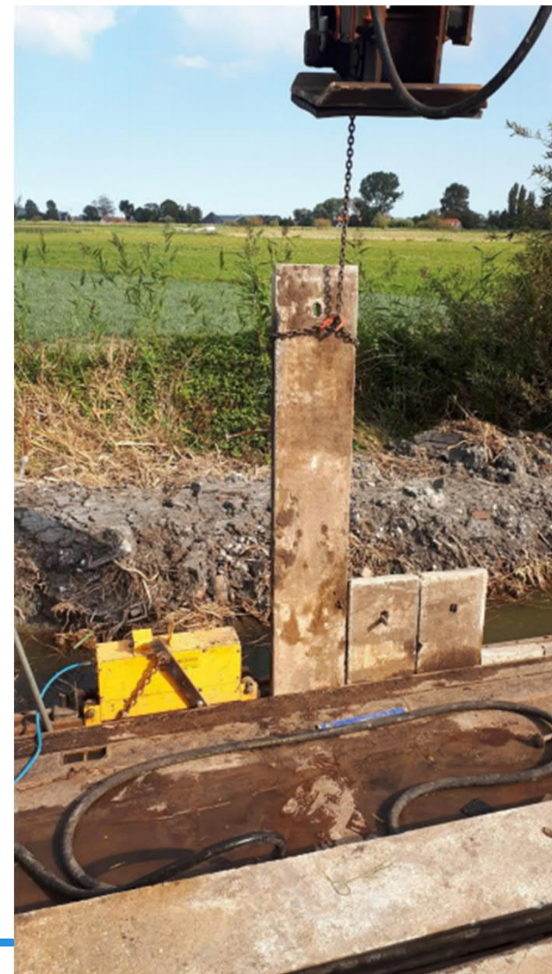
Figuur 2 zetten van betonplanken met spuitlans
