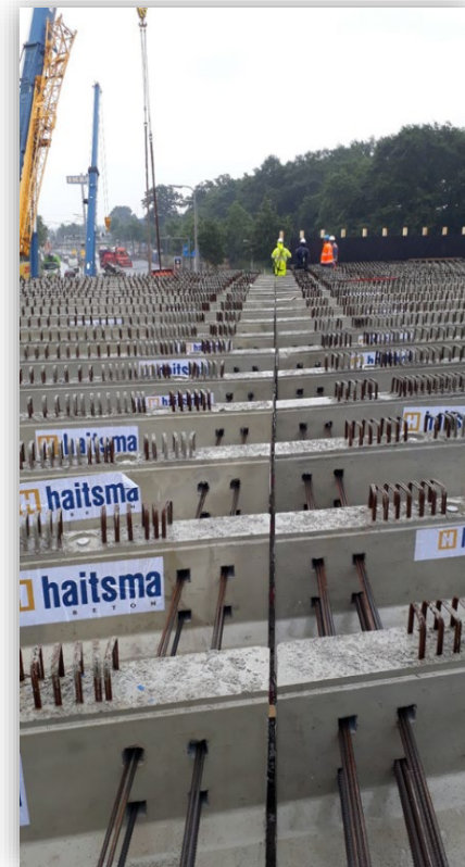
Foto-5 Wapening t.b.v. reguliere Hergebruik Prefabrikators, 19 september 2021 19
