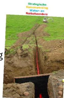
Handvatten kabels in en nabij waterkeringen
